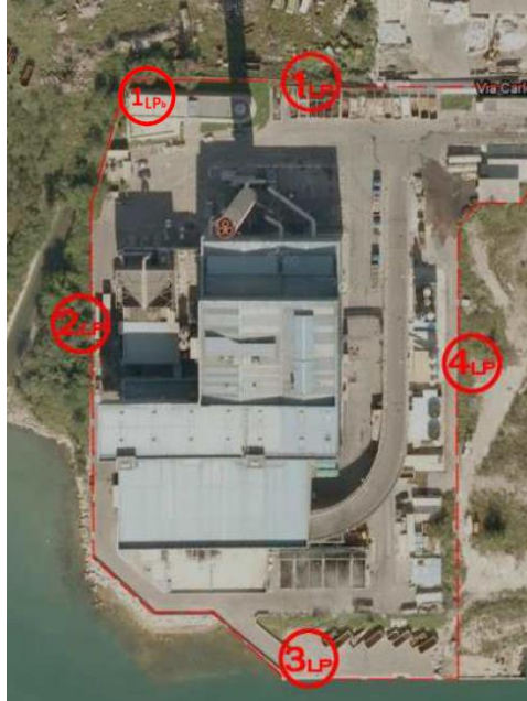
Figura 26: Punti di misura al limite della proprietà
